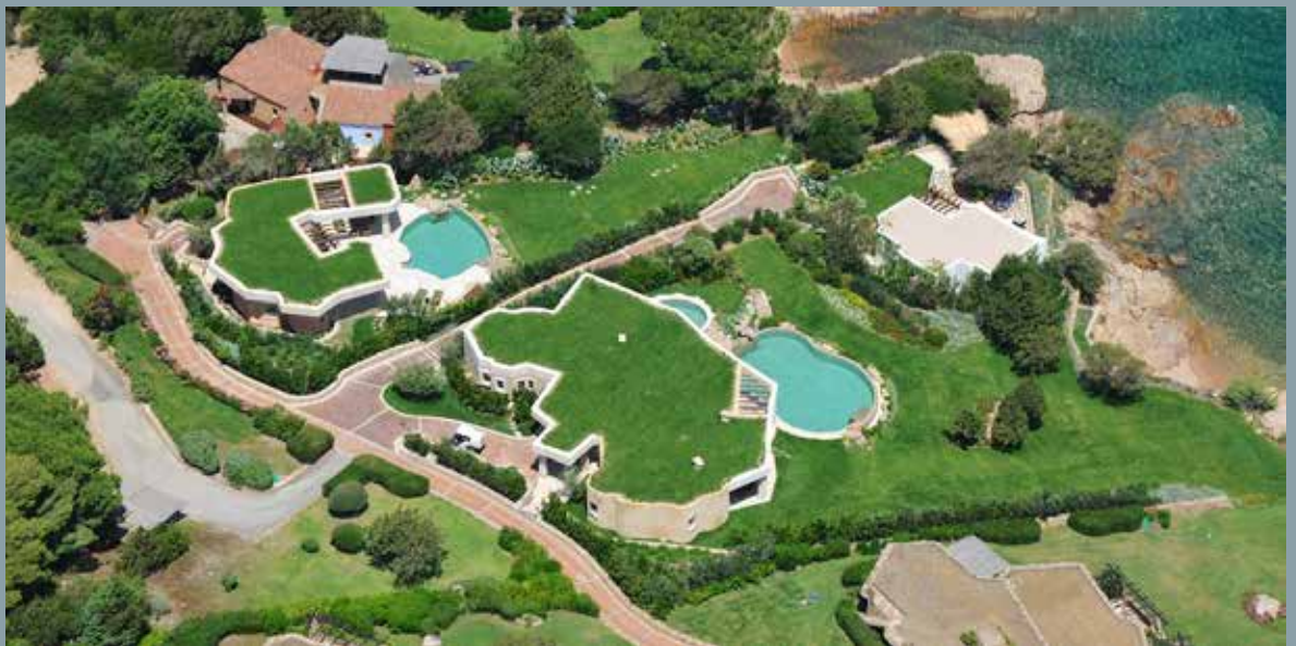
Nella foto: grandi cantieri, ampliamento Hotel Pitrezza
